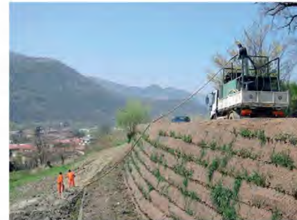
Foto 7.3: Idrosemmina a spessore su terra rinforzata (aprile 2002) Atina (FR) - Foto P. Cornelini
