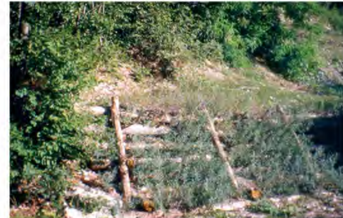
Foto 7.20: Palificata Roma (giugno 2003) Acqualagna (PU) - Foto P. Cornolini
