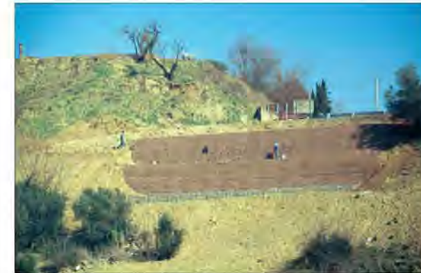
Foto 7.24: Terra rinforzata rinverditata in costruzione (novembre 2000) Bernalda (MT) - Foto A. Trivisani
